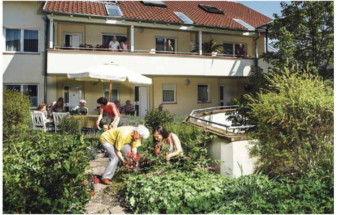
Im „Schwanenhof“, einstmals ein leerstehendes Gebäude, sind nun 16 barrierefreie betreute Wohnungen samt weiterer Gemeinschaftsräume für alle Menschen im Dorf entstanden. FOTO: FREY ARCHITEKTEN / WWW.FREYGRUPPE.DE
