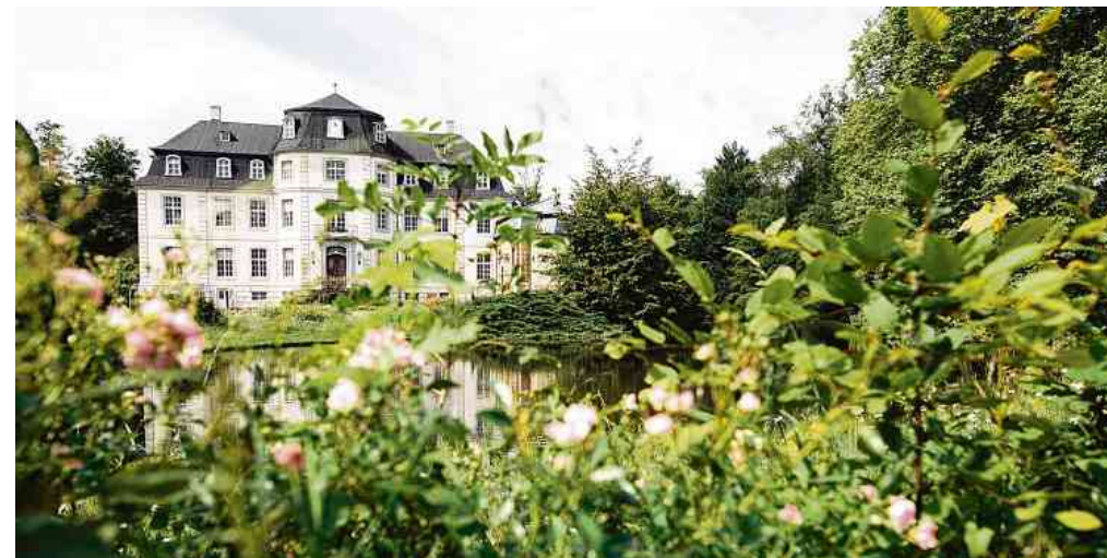
Vom Braunkohleabbau schwer beschädigt: Schloss Türnich
